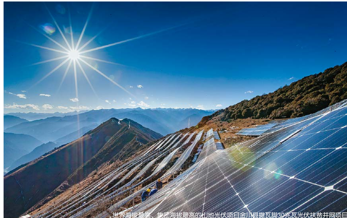
世界海拔最高、集团海拔最高的山地光伏项目金川县撒瓦脚30兆瓦光伏扶贫并网项目
