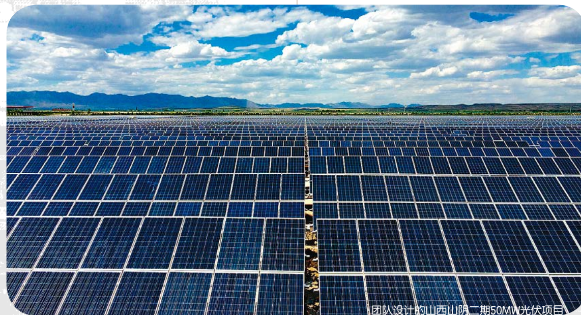
团队设计的山西山阴二期50MW光伏项目
