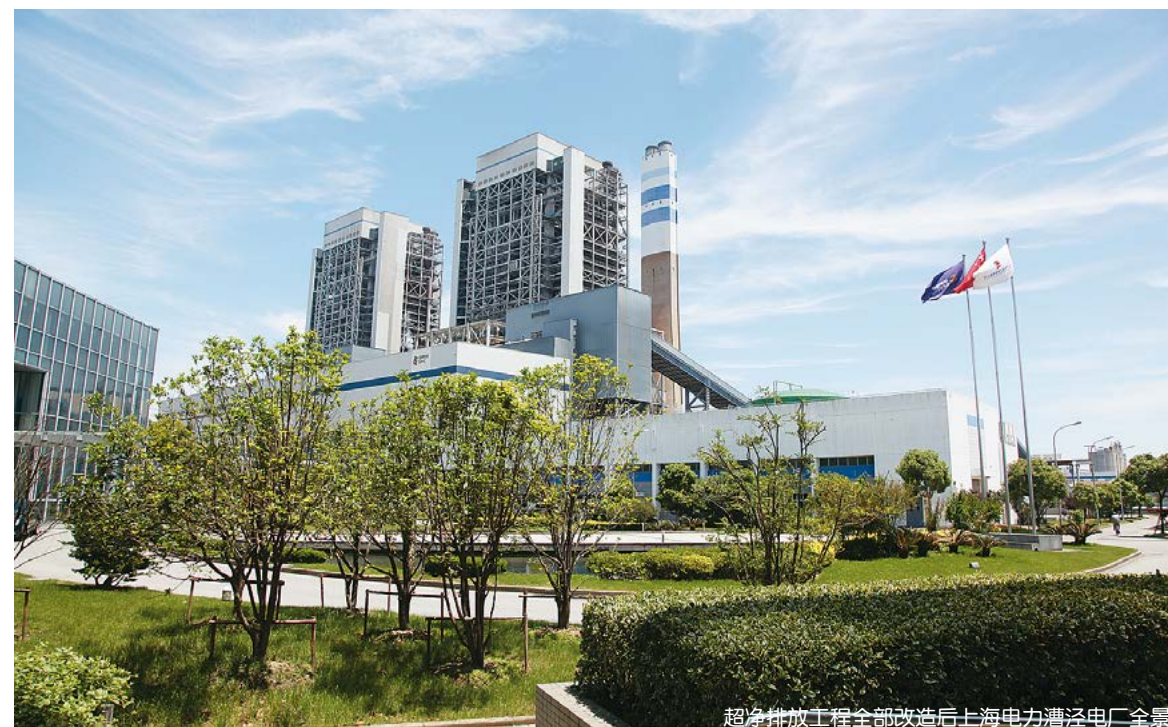
超净排放工程全部改造后上海电力漕泾电厂全景
