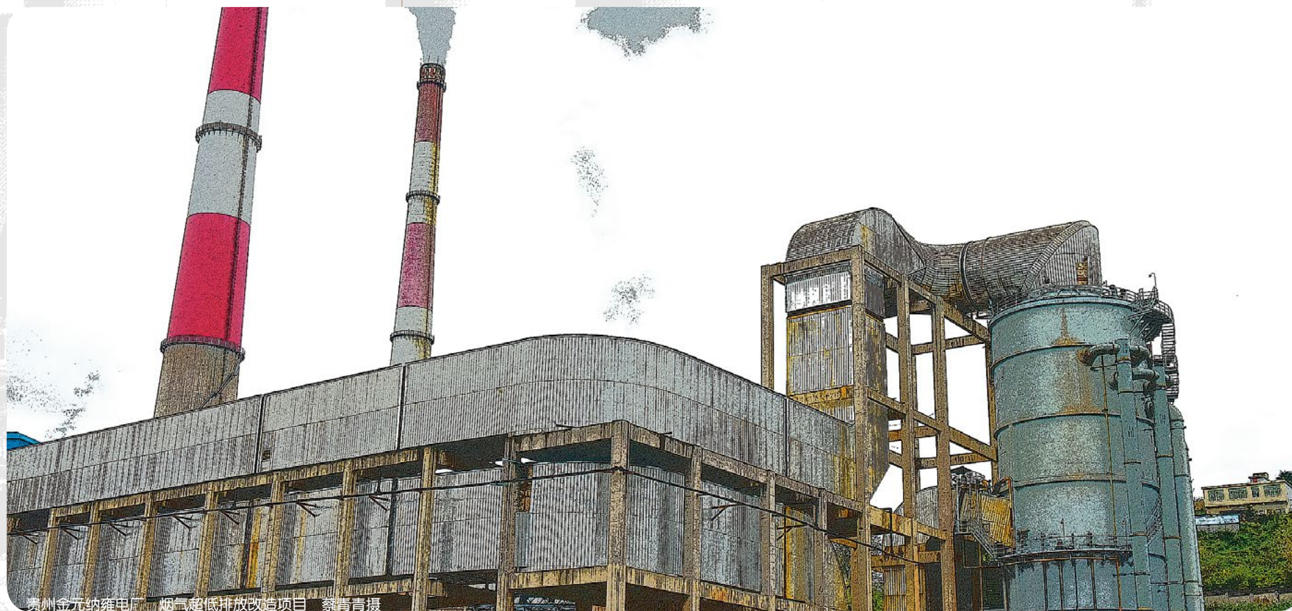
贵州金元纳雍电厂 烟气超低排放改造项目 蔡青青摄
