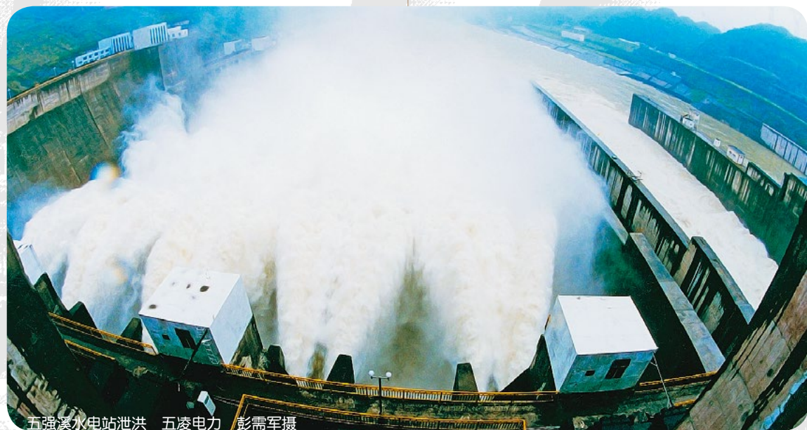
五强溪水电站泄洪 五凌电力 彭需军摄
