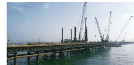
为周边居民修建码头
