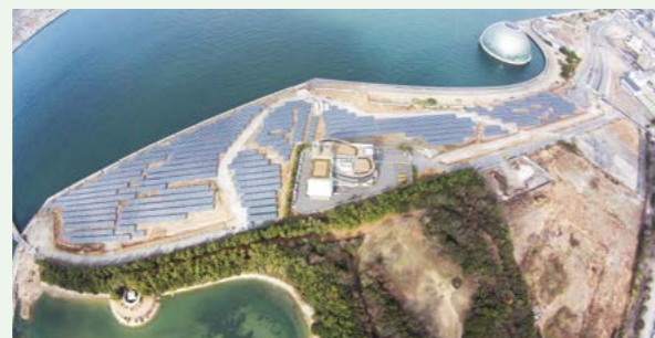
上海电力在日本大阪南港光伏项目
