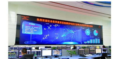
公众参观五凌电力发电集控中心
