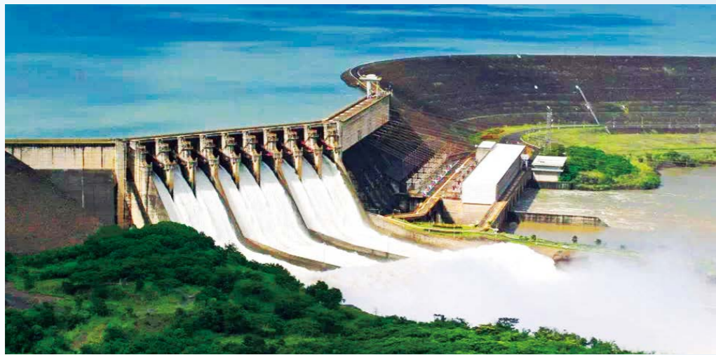
巴西圣西芒水电站
