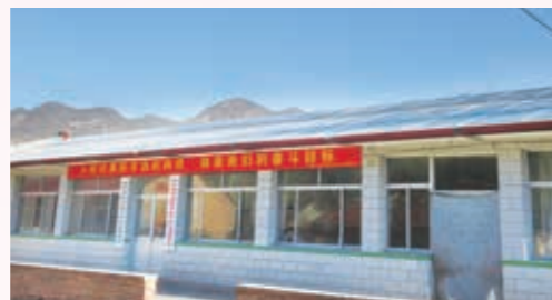
屋顶光伏发电项目
