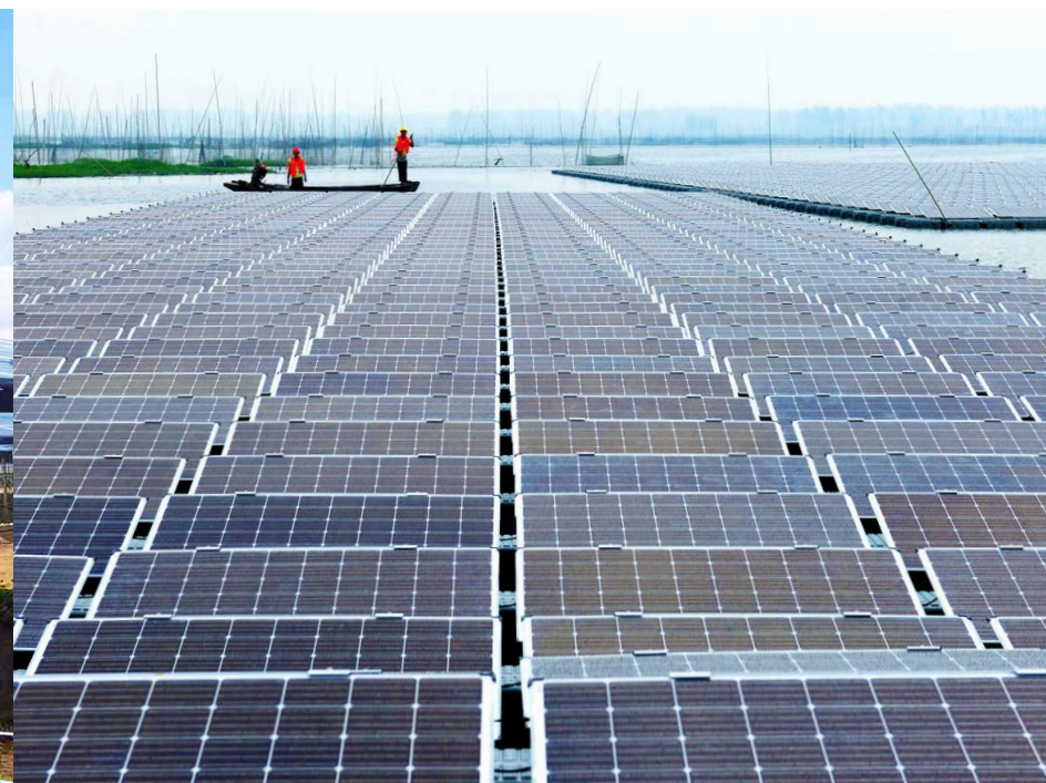
水上漂浮电站
