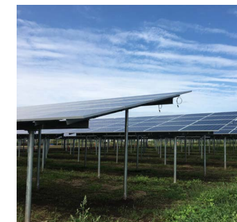
新疆无电地区光伏发电安装
