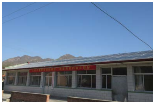
捐建 60 千瓦村委会屋顶光伏发电项目
