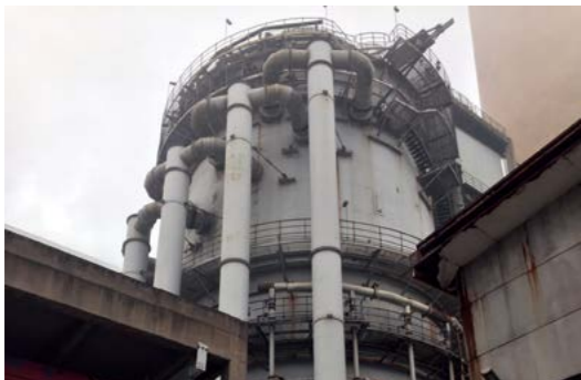
改造机组脱硫吸收塔
