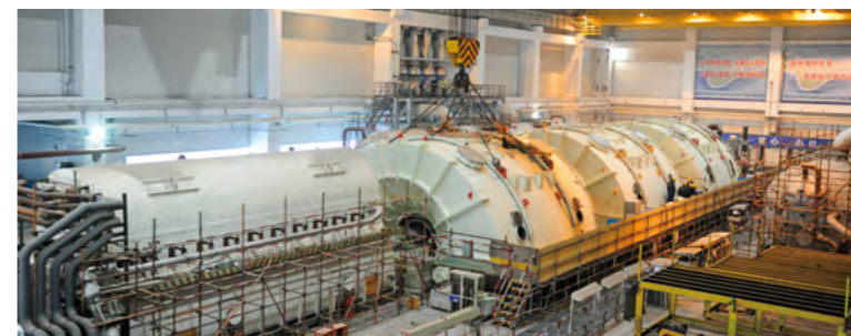
2014 年 12 月 18 日，海阳核电 1 号机组汽轮机扣缸工作圆满完成。
