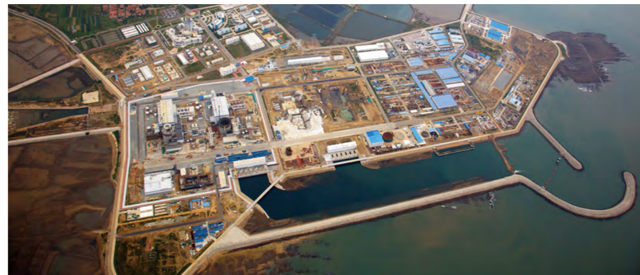
海阳核电项目航拍图。
