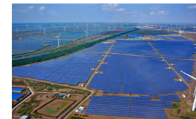
东台光伏电站，总装机容量 5 万千瓦，该电站建在沿海滩涂上，不占用耕地。
