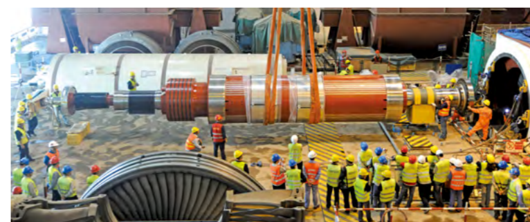
2014 年 9 月 20 日，海阳核电 2 号机组发电机穿转子圆满完成。
