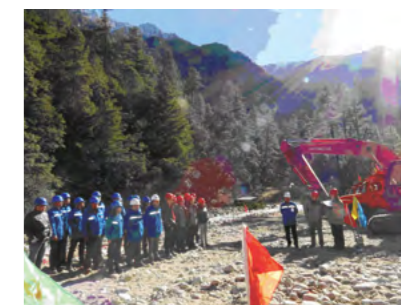
2013 年，波罗水电站主体工程开工。
