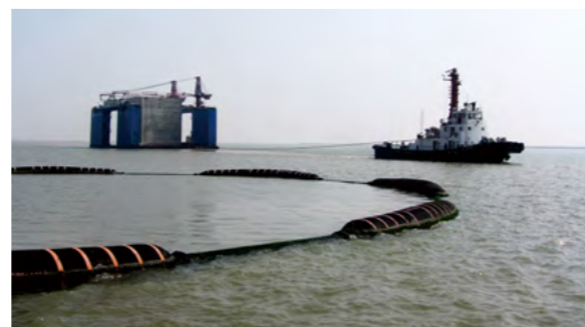
建设中的江苏滨海港煤炭专业码头。
