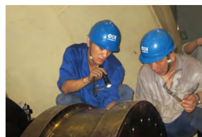
2014 年供热前，抚顺热电分公司进行供热设备改造、检修。
