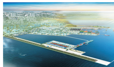
锦州港煤炭码头一期工程建设3个7万吨级的煤炭装船泊位，形成3500万吨/年的装船能力，并与锦赤铁路、赤大白铁路构筑起我国又一条北煤南运的下海通道。工程于2011年开工建设，目前正按计划施工。
