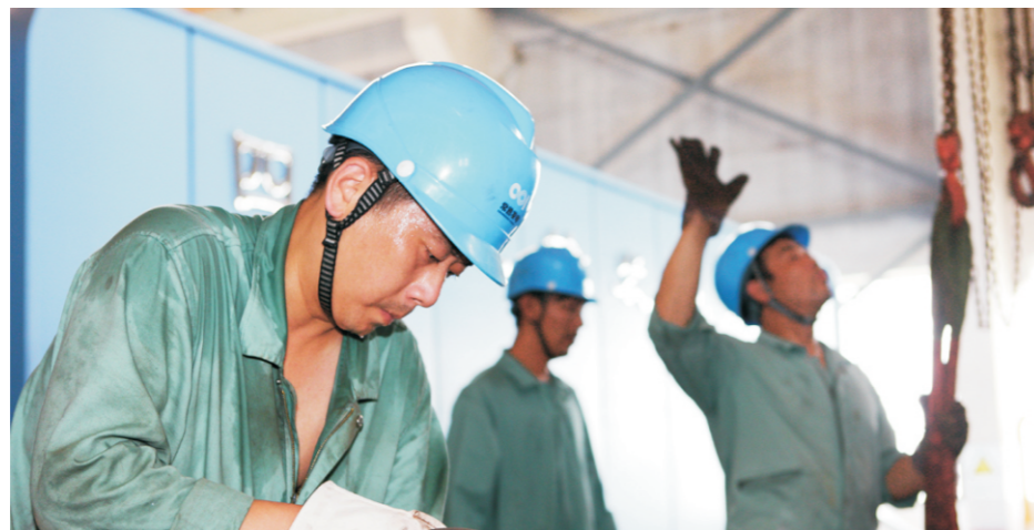
常熟电厂机炉车间检修员工在迎峰度夏期间抢修保发电。
