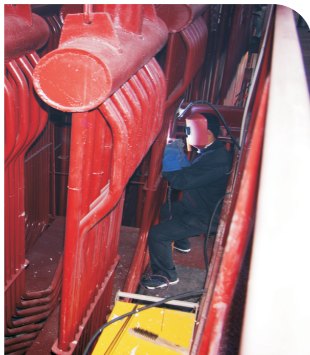
焊工技能操作训练。
