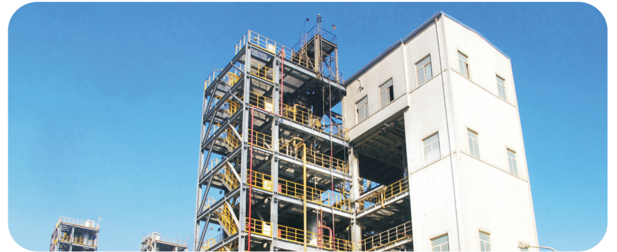
西宁多晶硅项目低压氯化装置。
