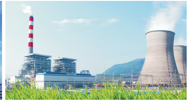
中电国际福溪2×60万千瓦超临界燃煤机组新建工程项目获得“中国电力优质工程奖”。
