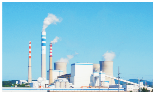
中电国际清河项目“上大压小”技改二期1×60万千瓦超临界工程获得“国家优质工程奖”。
