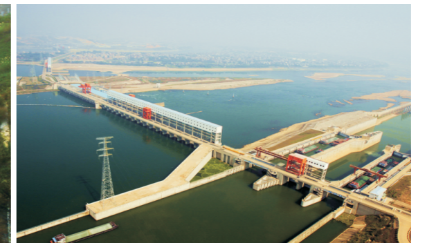
长洲水利枢纽船闸和外江大坝。
