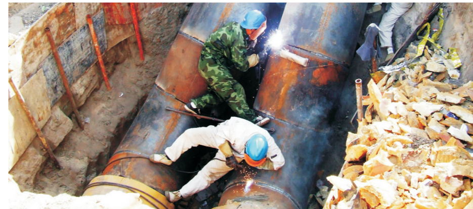
2013年供热前，通辽热电厂对热网主分支进行检修。
