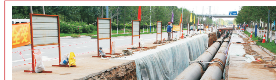
2013年供热前，通辽热电厂对热网主分支进行检修。
