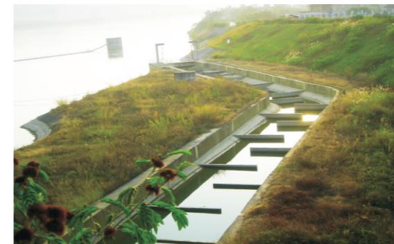
长洲水利枢纽建设了总长1443.3米的垂直竖缝式鱼道。
