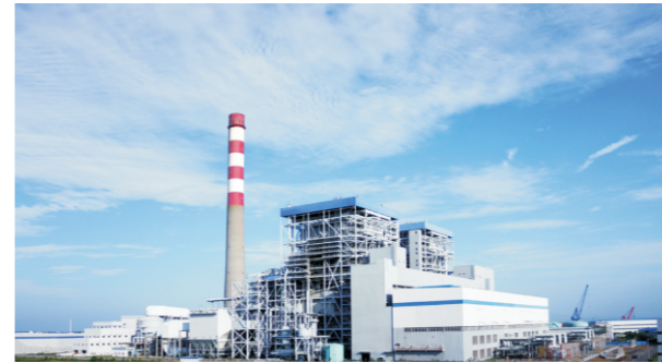
中电国际芜湖电厂二期2×66万千瓦“上大压小”工程获得“国家优质工程奖”。
