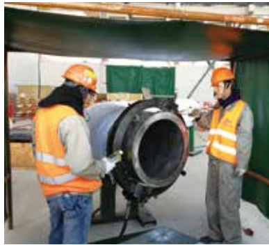
12月31日，1号核岛主管道施工开始。
