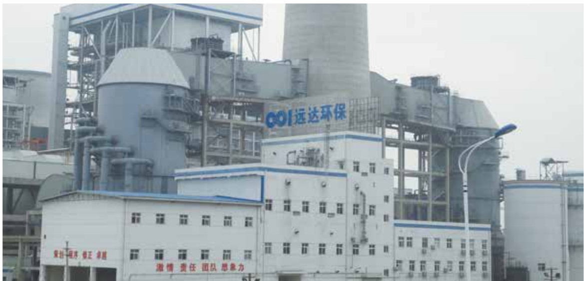
远达环保建设运营的国内首个取消旁路烟道 60 万千瓦等级项目——贵溪三期 2×64 万千瓦项目脱硫特许经营项目。
