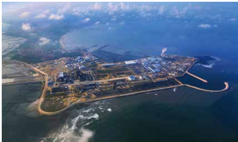
▲ 山东海阳核电项目航拍图。
