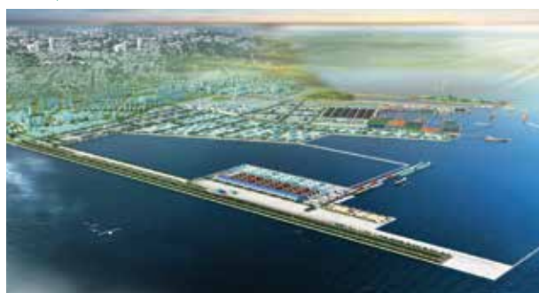
锦州港煤炭码头一期工程建设3个7万吨级的煤炭装船泊位，形成3500万吨/年的装船能力，并与锦赤铁路、赤大白铁路构筑起我国又一条北煤南运的“下海通道”。工程于2011年开工建设，计划2014年建成投运。
