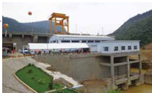
越南松泵六两台 1.45 万千瓦水电项目设备安装工程。
