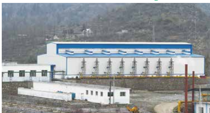
金元集团林华煤矿瓦斯发电站及发电机组。
