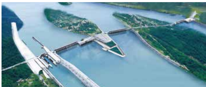
长洲水利枢纽工程。
