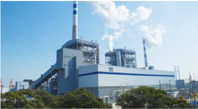
上海电力吴泾热电厂利用微颗粒聚合技术减少PM2.5排放。微颗粒聚合增效装置投运后，电除尘器出口PM2.5排放浓度比投运前下降30%。
