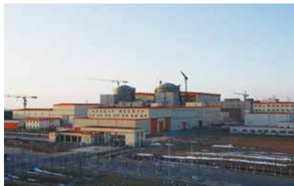
红沿河核电项目1、2号机组整体侧景。
