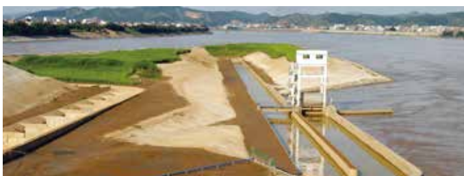
长洲水利枢纽工程鱼道。
