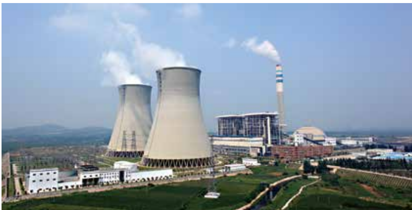
平顶山第二发电厂一期2×100万千瓦机组工程获2012年度国优金奖。
