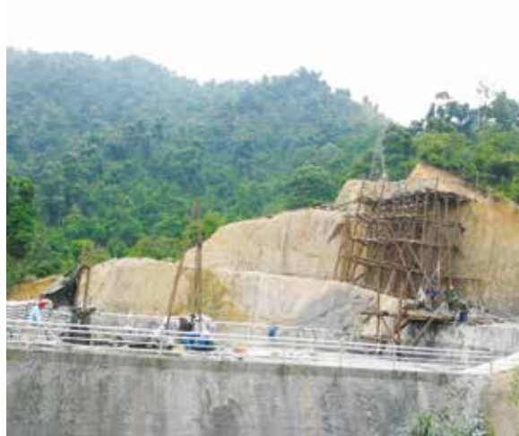
江西公司小水电大坝渗漏灌浆治理。
