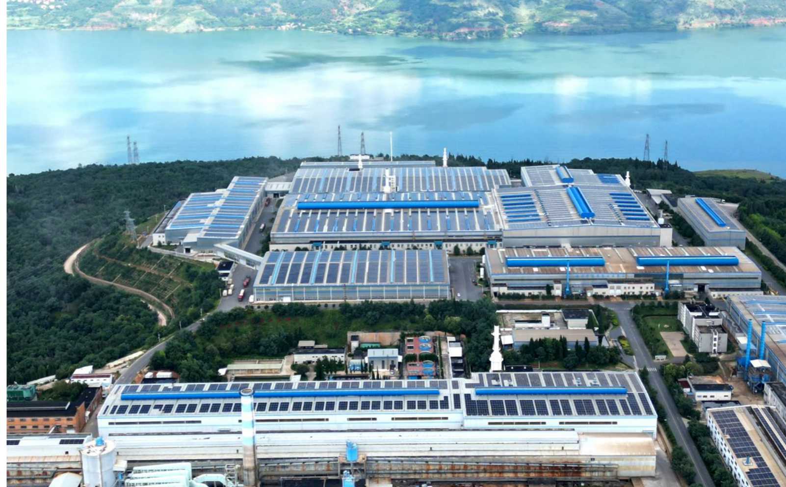
云南国际昆明阳宗海铝产业园区绿色智慧能源示范项目一期工程
