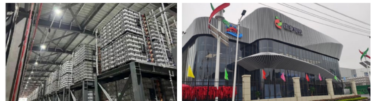
湖州“和平共储”现场图
