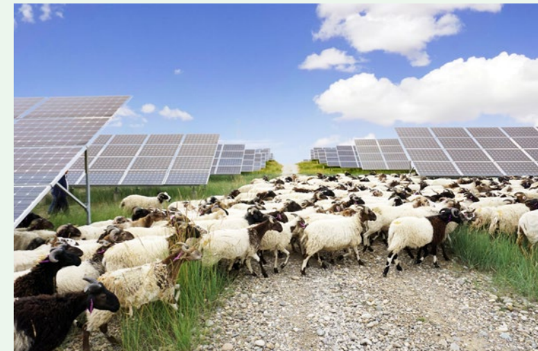
光伏+养殖 ：黄河公司在荒漠化土地建设光伏电站，使原本的荒芜之地长出茂密的牧草，滋养着几千只“光伏羊”。
