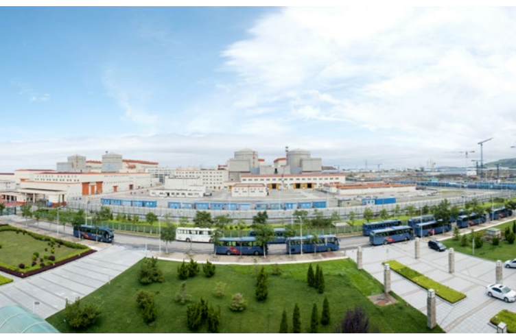
国家电投控股建设并负责运营管理的在东北的首座核电站——红沿河核电站一期和二期工程 6 台机组全面投产
