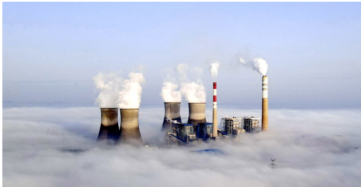
重庆公司合川双槐电厂建成我国首个燃煤电厂万吨级二氧化碳捕集装置，捕集纯度高于 99.5%，捕集效率可达 99%
