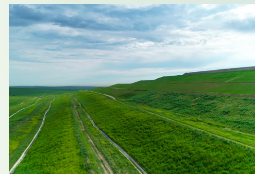
白音华露天矿北排土场治理后
