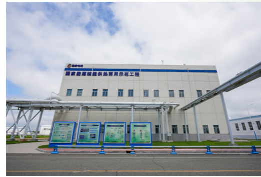
“暖核一号”核能供热首站
