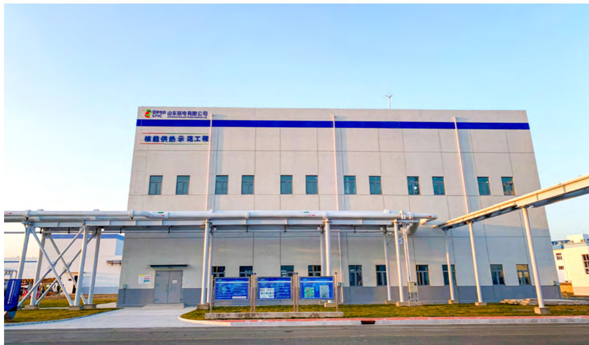
核能供热示范工程
