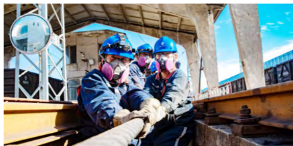
内蒙古公司通辽发电总厂职工在狭窄的地沟里，正在对卸储煤系统翻车机重车铁牛钢丝绳进行检修
