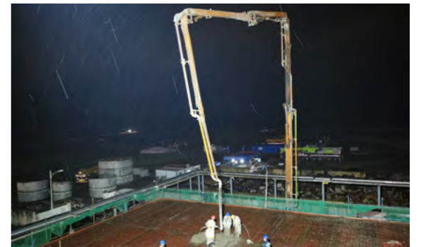
黔东电厂超低排改造施工
