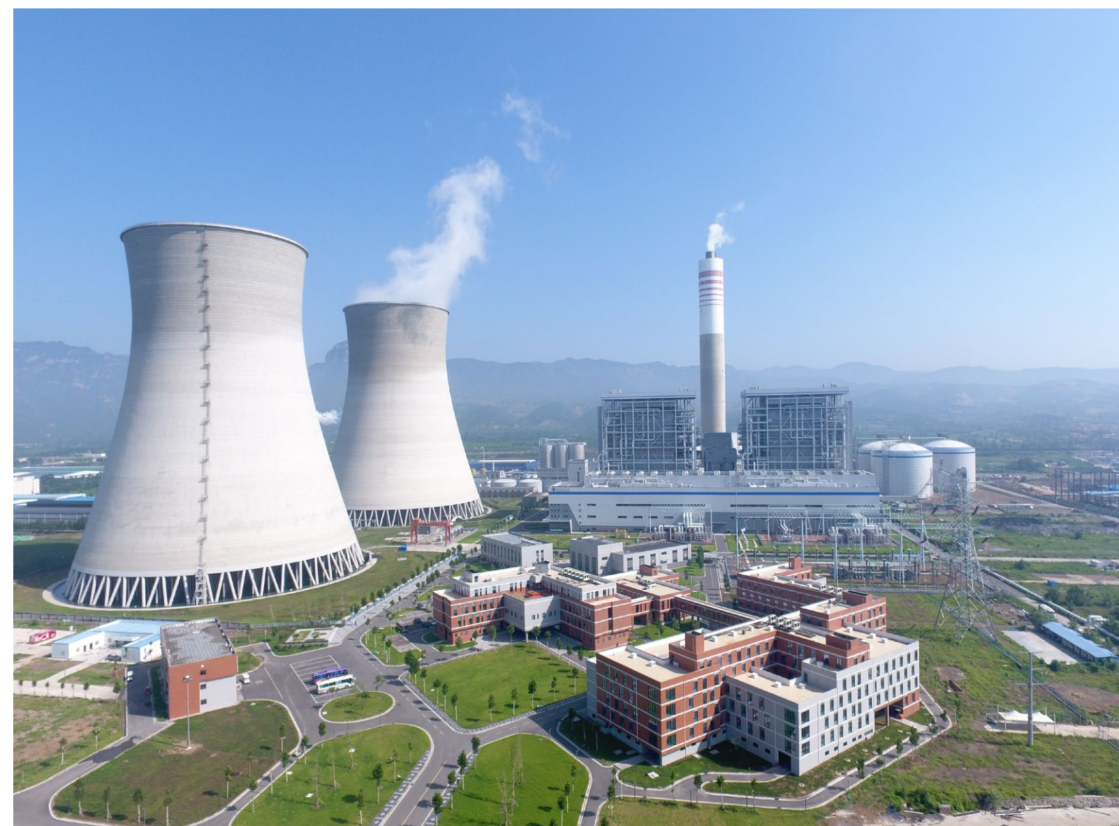
沁阳1000MW一次中间再热超超临界示范机组
