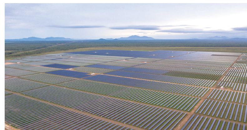
2019年8月，澳大利亚霍顿一期100MWp光伏电站顺利实现全容量并网发电。
