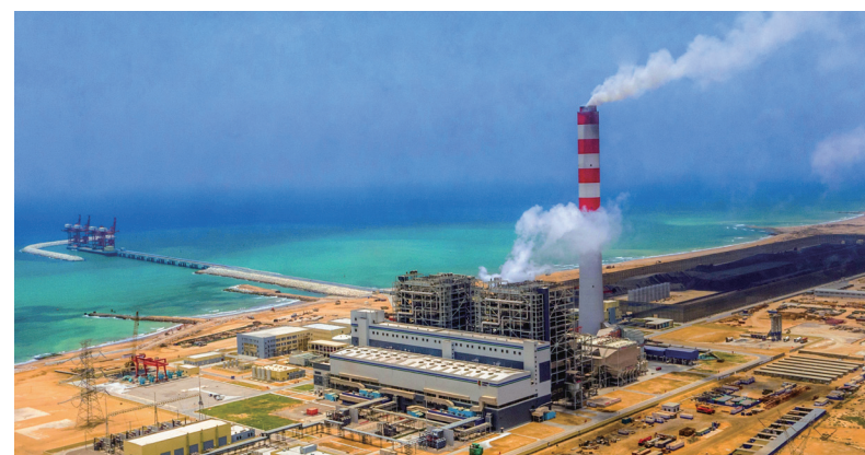
2019年8月，巴基斯坦中电胡布燃煤电站投入商运。
