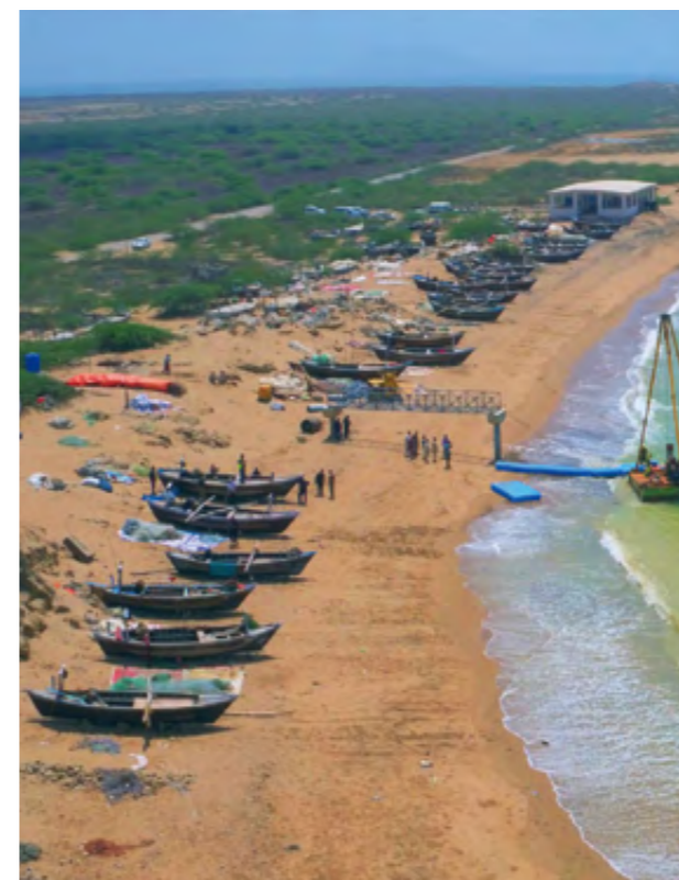
中电胡布渔民码头建设现场
