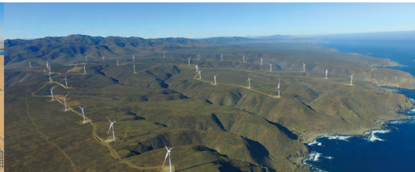
2018年8月,智利蓬塔80MW风电项目顺利竣工,这是我国在智利投资建成的第一座风电场,可满足13万户家庭的用电需求,每年可减少15.7万吨的碳排放
