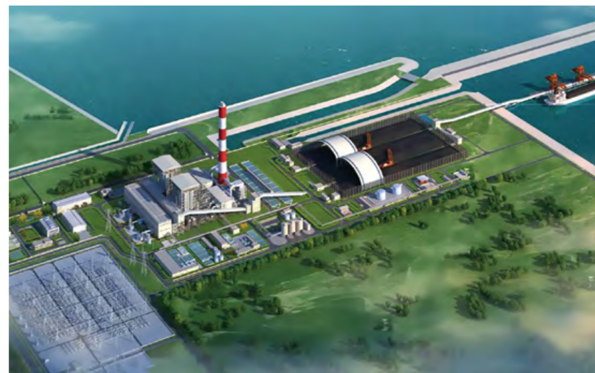
越南永新燃煤电厂一期项目
