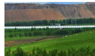
霍林河运煤长廊。
