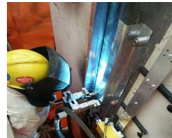
焊接作业配备焊接烟尘净化器，吸收焊接烟尘，降低对作业人员的职业危害。
