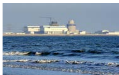
海阳核电站建设现貌。
