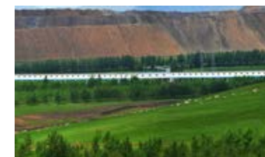
霍林河运煤长廊。
