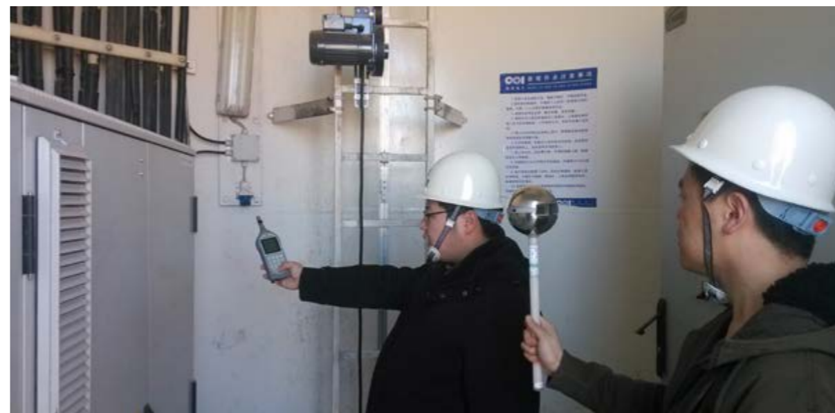
风力发电场在配电室测量辐射，保障员工健康。
