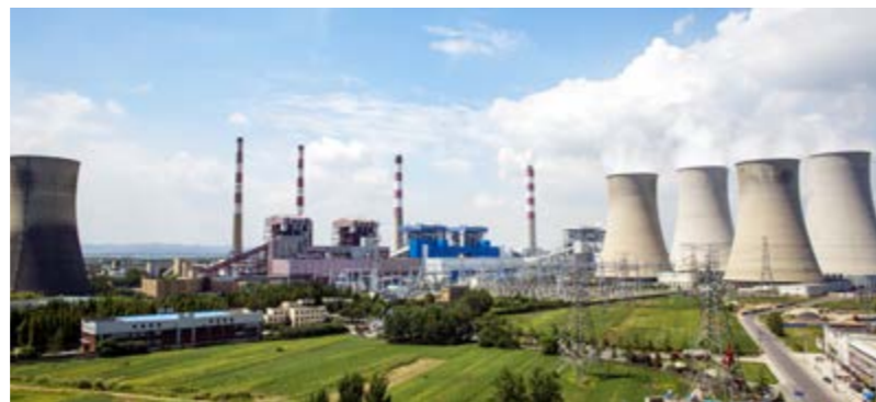
中电国际平圩电厂三期 2×100 万千瓦工程 2015 年 9 月实现“双投”，其中 5 号机组创造了全国百万机组 168 后连续安全稳定运行 105 天的长周期记录。
