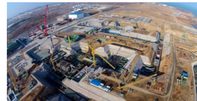
CAP1400 示范工程建设现貌。
