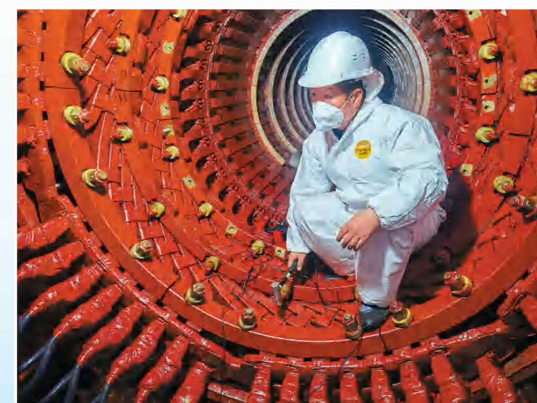
国家电投河南公司派出的技术人员在土耳其项目大修中进行电气模态振动试验
