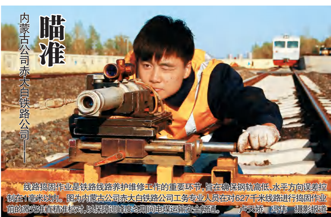
线路捣固作业是铁路线路养护维护工作的重要环节,旨在确保钢轨高低、水平方向误差控制在1毫米以内。图为内蒙古公司赤大白铁路公司工务专业人员在对627千米线路进行捣固作业时,对钢轨高低误差进行精确控制。 卢昊昊 摄
