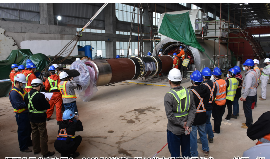
江西公司分宜电厂2#660MW扩建工程#2发电机电穿转子作业 钟军 摄
