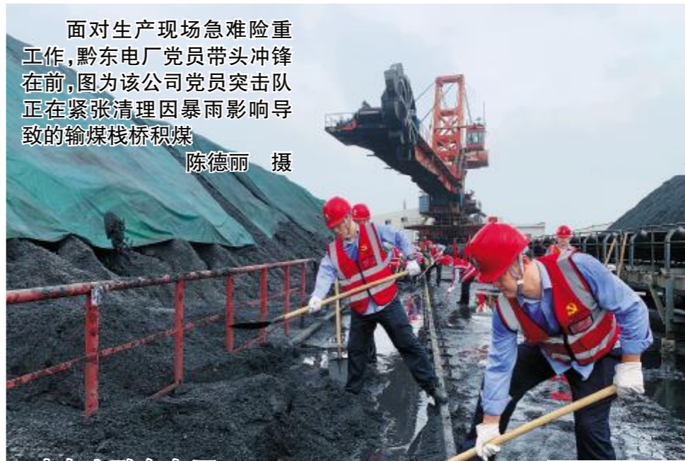
面对生产现场急难险重工作,黔东电厂党员带头冲锋在前,图为该公司党员突击队正在紧张清理因暴雨影响导致的输煤栈桥积煤。陈德丽 摄
