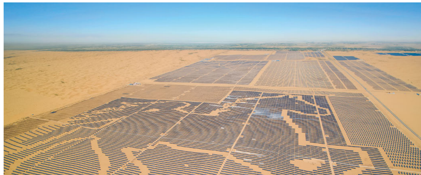
2018年11月,全国最大沙漠生态光伏电站——达拉特旗光伏发电应用领跑者基地(骏马图)并网发电,预计每年可发电61423.43万千瓦时,将治沙达1.2万亩
