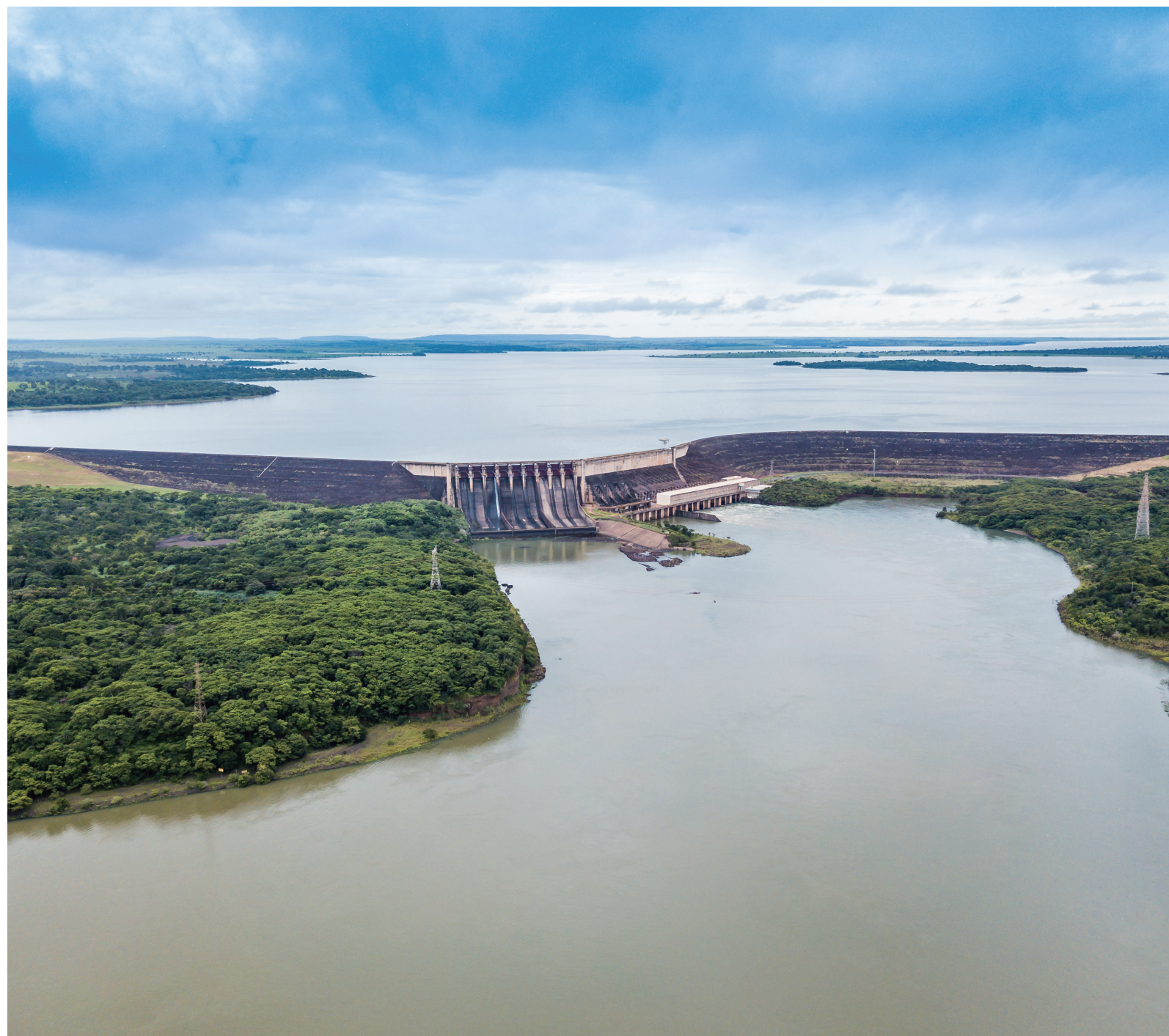
巴西圣西芒水电站
